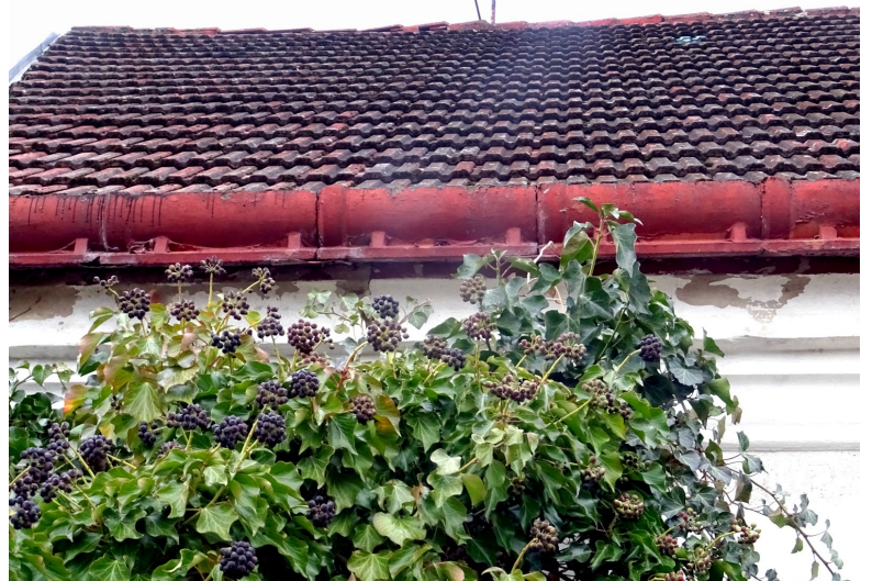
6. Ceramiczna rynna budynku przy ul. Polnej 1 (fot. Zb. Januszaniec).
